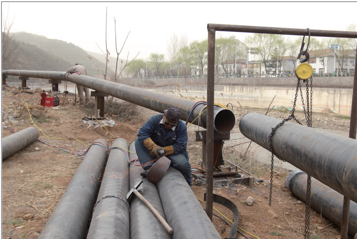
春暖花开,町店镇早安排,早动手,在去年镇区5村13家公建单位千余户居民实现集中供暖的基础上,居安思危,未雨绸缪,争分夺秒,抓紧施工,为今冬实现芦荡河沿岸村庄集中供暖奠定坚实基础。图为3月21日町店镇芦荡河畔施工人员正在加紧焊接输气管道。
